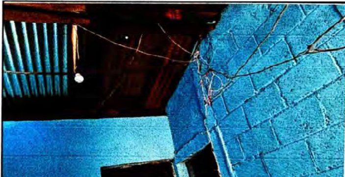
Foto 20: Reestructuración de red eléctrica en área de bodega, cocina, pasillo y dirección.
