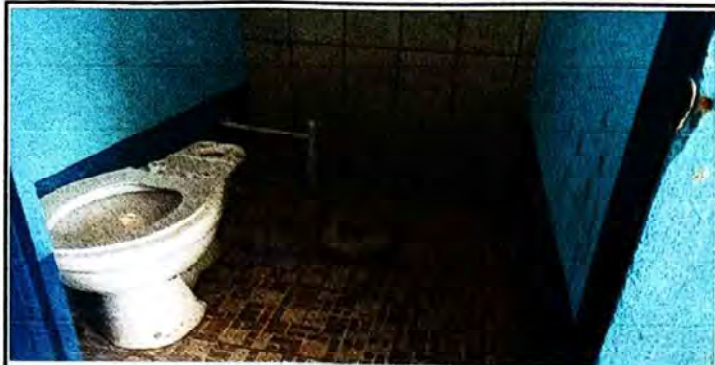
Foto 7: Cambio de Sanitario y reestructuración de red de drenajes
