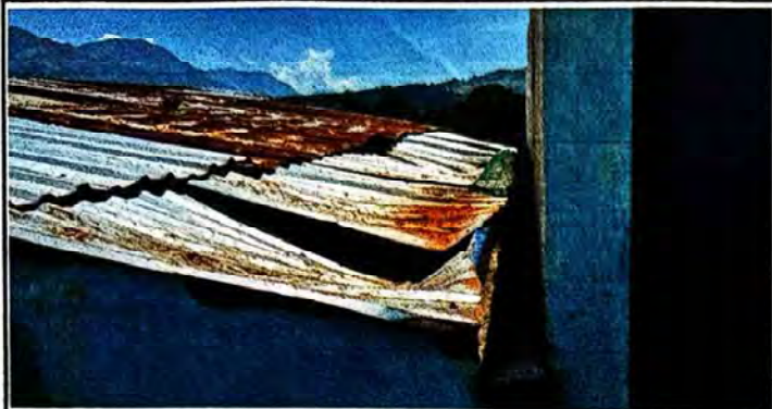
Foto 1: Sustrucción de estructura de techo en área del aula 10 y de los baños.
